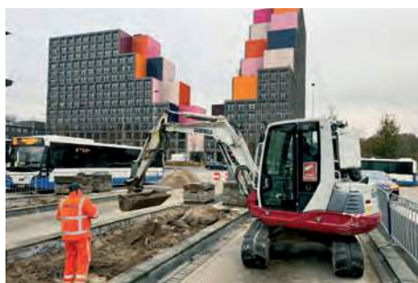
Werkzaamheden op station Holendrecht, Amsterdam.
