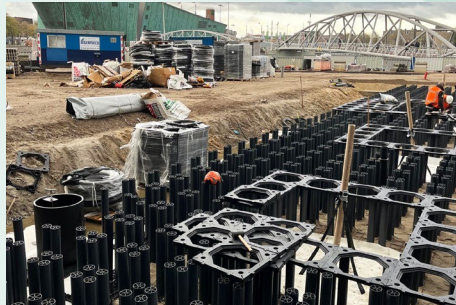
Boombunkers in aanleg.
