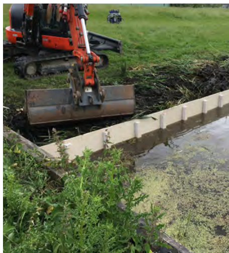
Aanbrengen van biobased beschoeiing.
