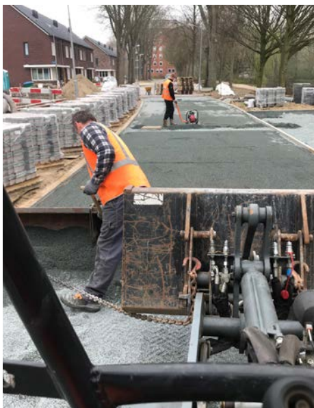
Germieco aan het werk in de Coornhertstraat, Heemskerk.
